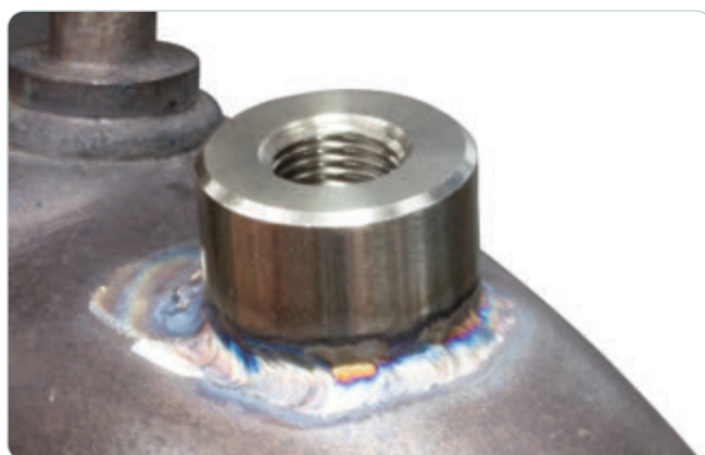
6. HJS Fitting einsetzen und verschweißen.
