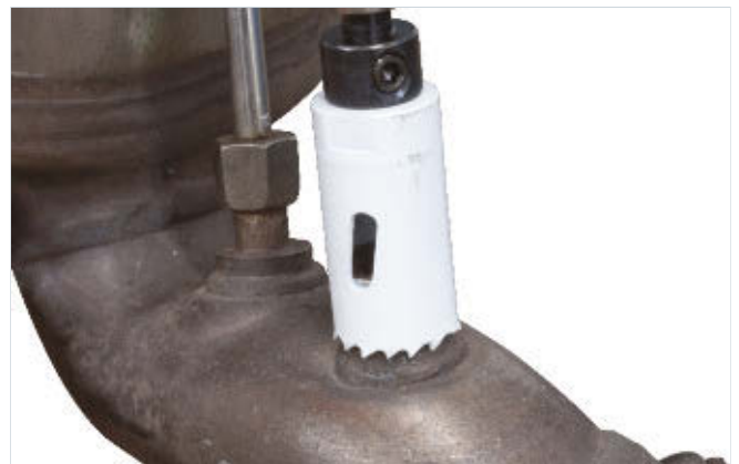
4. Temperatursensoranschluss mit einer Lochsäge (Ø 25 mm) ohne Zentrierbohrer ausschneiden.
