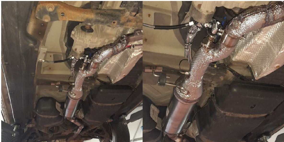
Abbildung 48: VW Touareg – Einbau des optimierten SCR-Systems und Kabelverlegung (Heizung, Injektor, AdBlue-Leitung und Masse).
